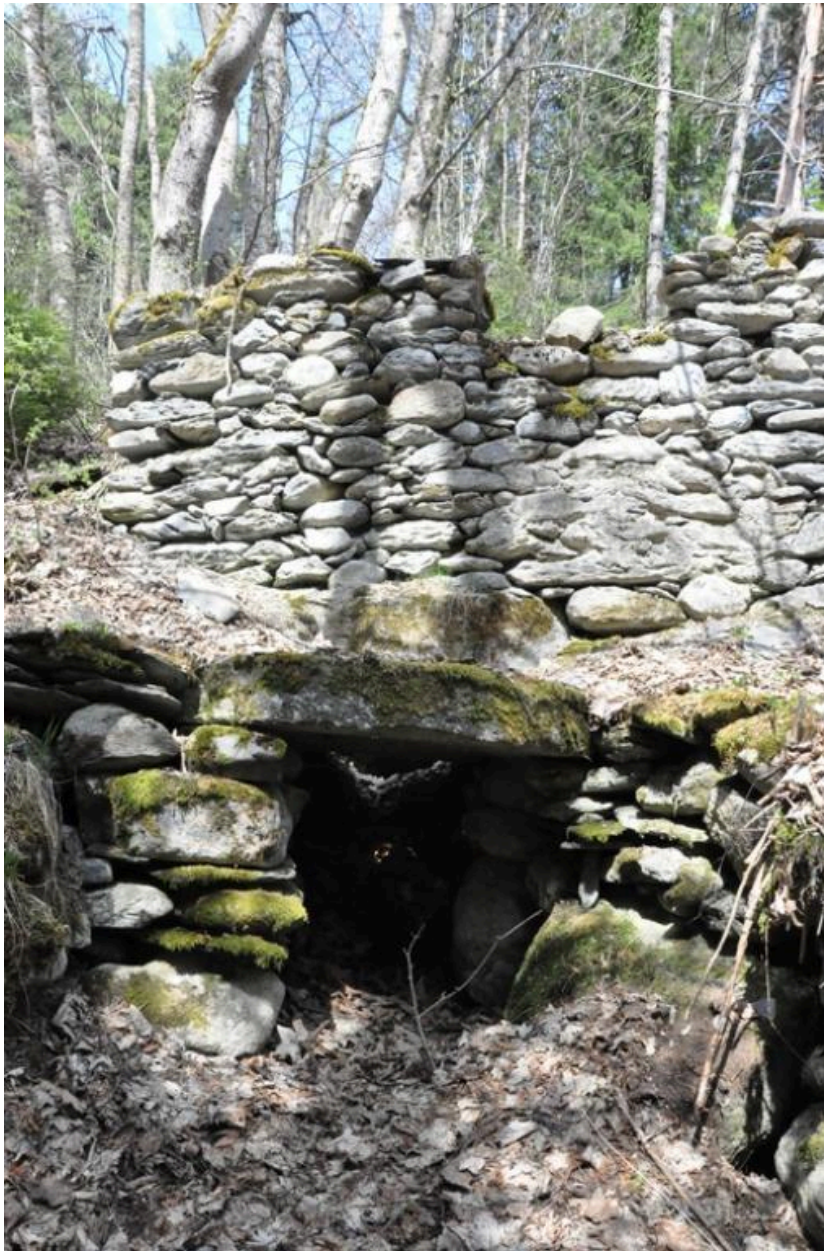
Canal de fuite du moulin aval.
