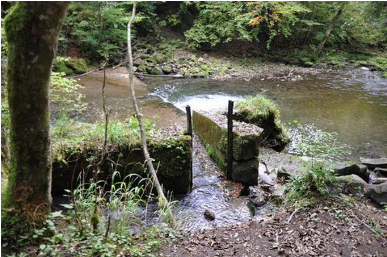
Vue des massifs supportant la trappe de la prise d'eau
