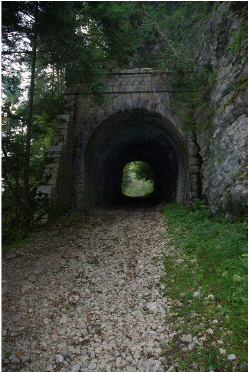
Ancien tracé du chemin de fer : tunnel
