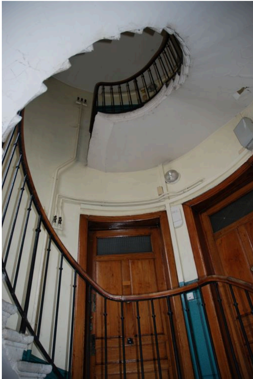
Vue intérieure, dernier niveau de la cage d'escalier
