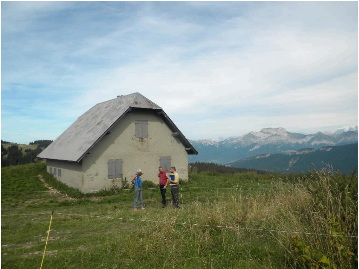
Bâtiment d'habitation : vue de la façade principale en mur pignon.
