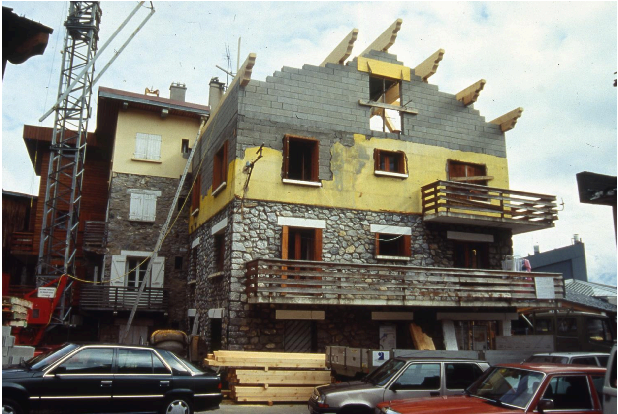
Élévation sud pendant les travaux. Phase 1
