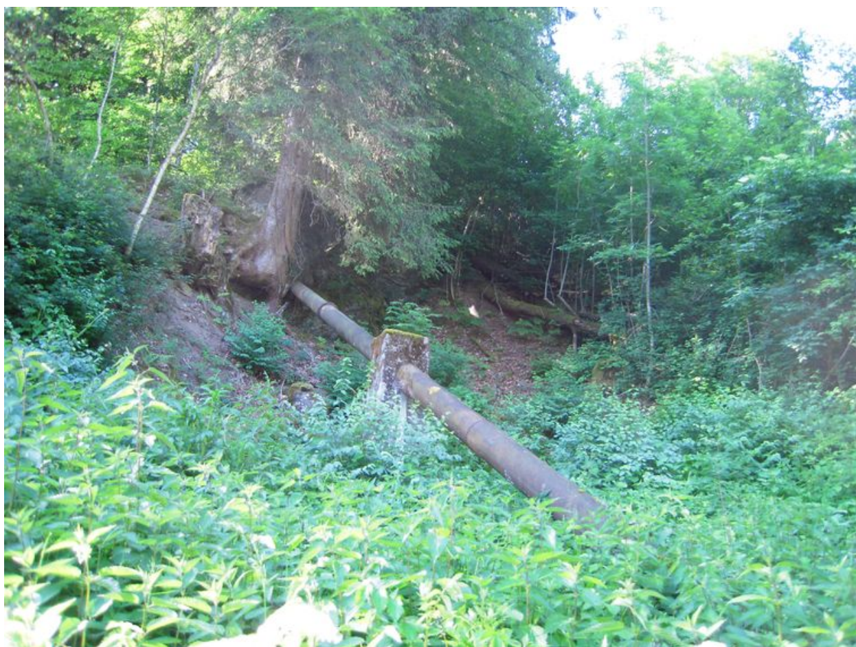
Vue de la conduite forcée.
