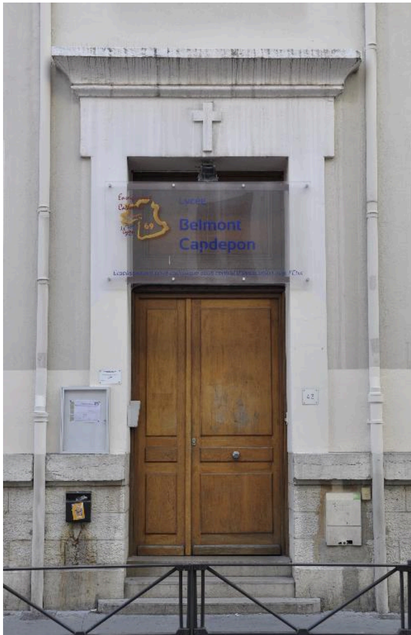
Bâtiment sur rue, porte ouvrant sur rue (43 rue Pasteur)
