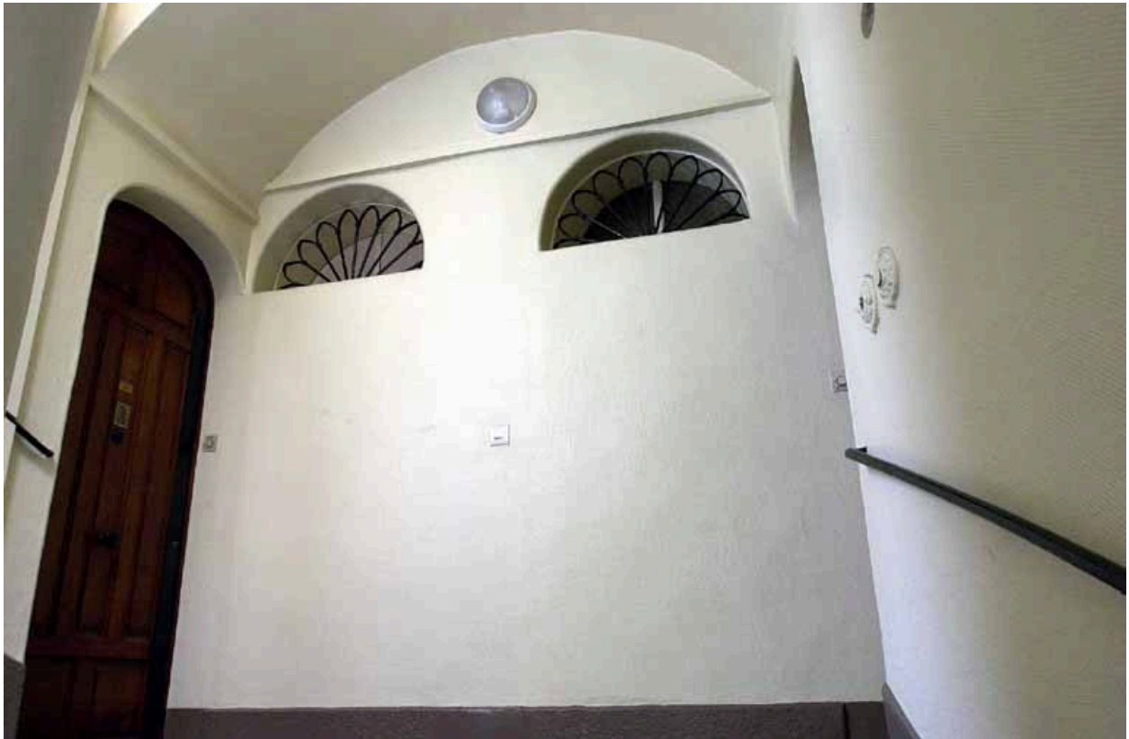
Corps de bâtiment ouest : porte et fenêtres palières
