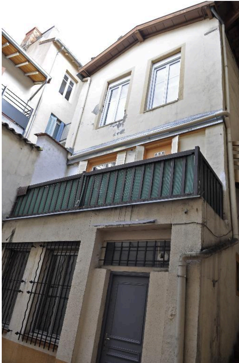
Bâtiment sur cour, vue générale
