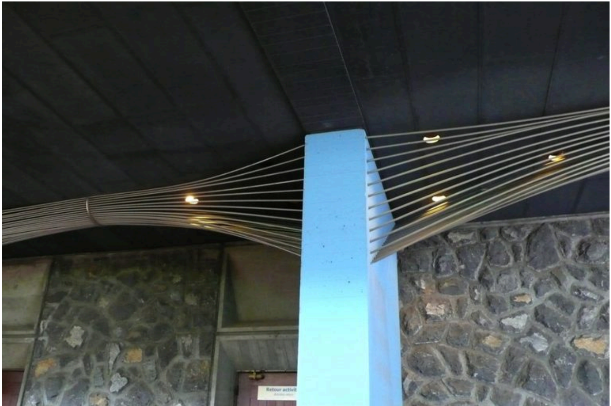
Détail de l'attache des faisceaux sur un pilier
