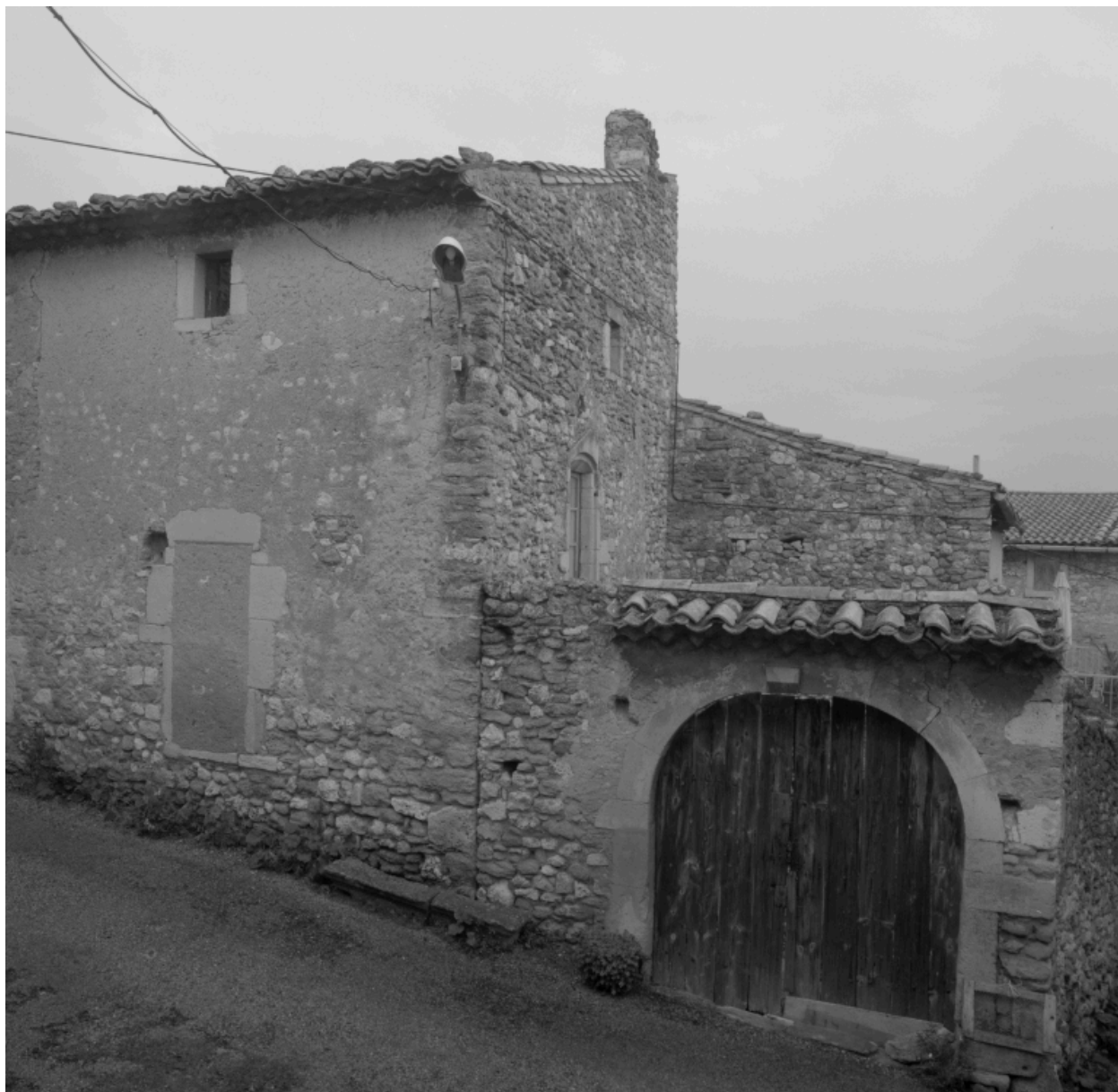
Vue partielle d'une maison du village (F2 624) : portail d'entrée sur la cour.
