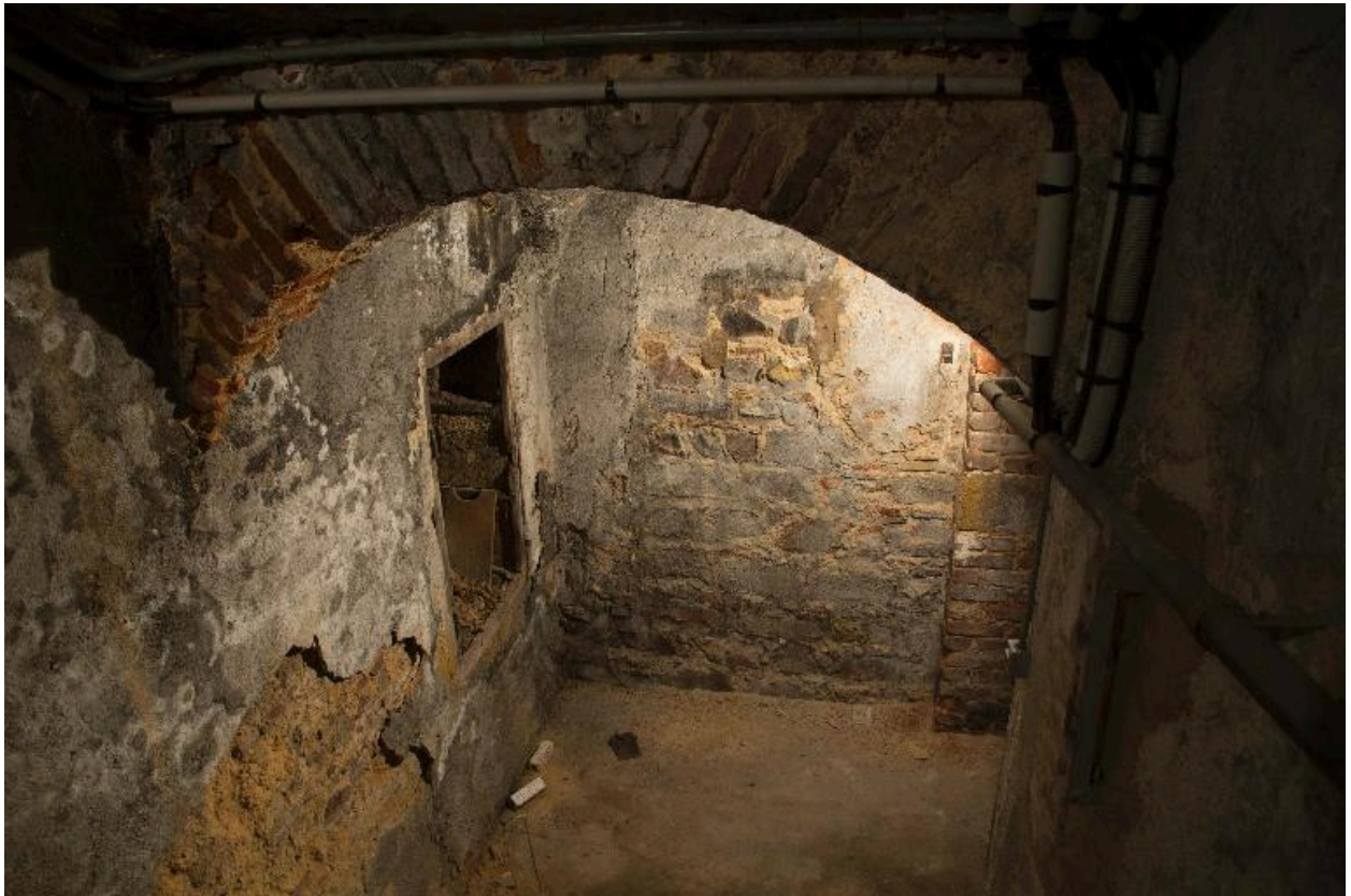
Bâtiment G. Accès au sous-sol
