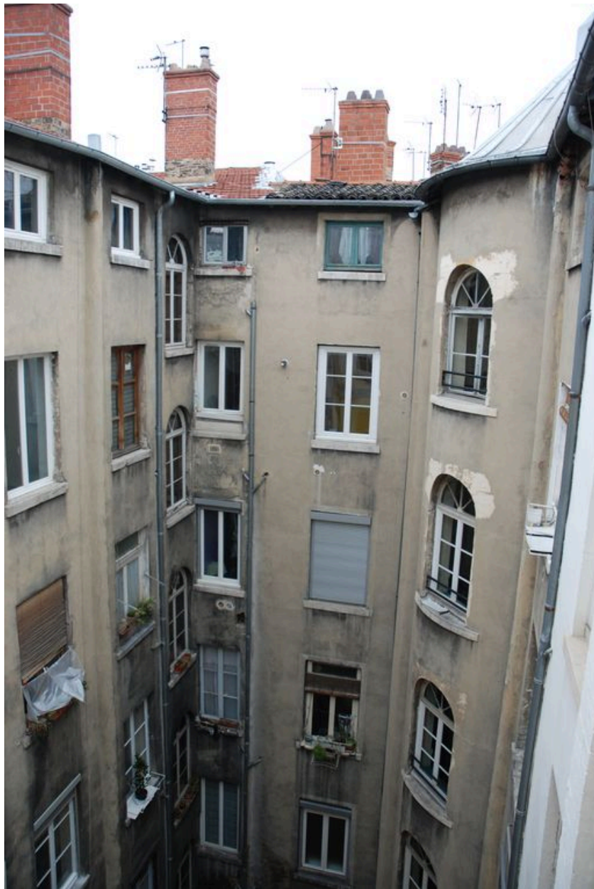
Elévation sur cour, tour d'escalier et étage de comble
