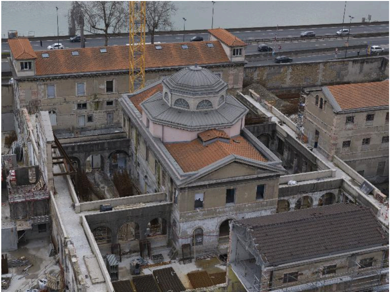
Etat en 2014 : la partie centrale, vue en plongée depuis l'ouest
