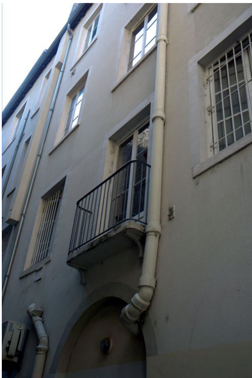
Elévation postérieure, détail
