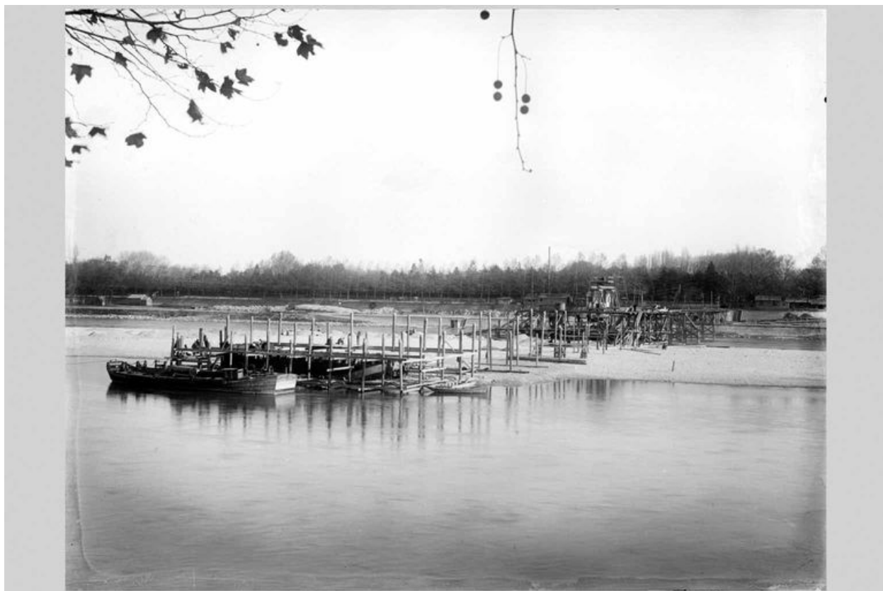
La construction du pont de la Boucle. Implantation des pieux. Photogr., [1902] (Arch. mun. Lyon. 15 Ph 1802)
