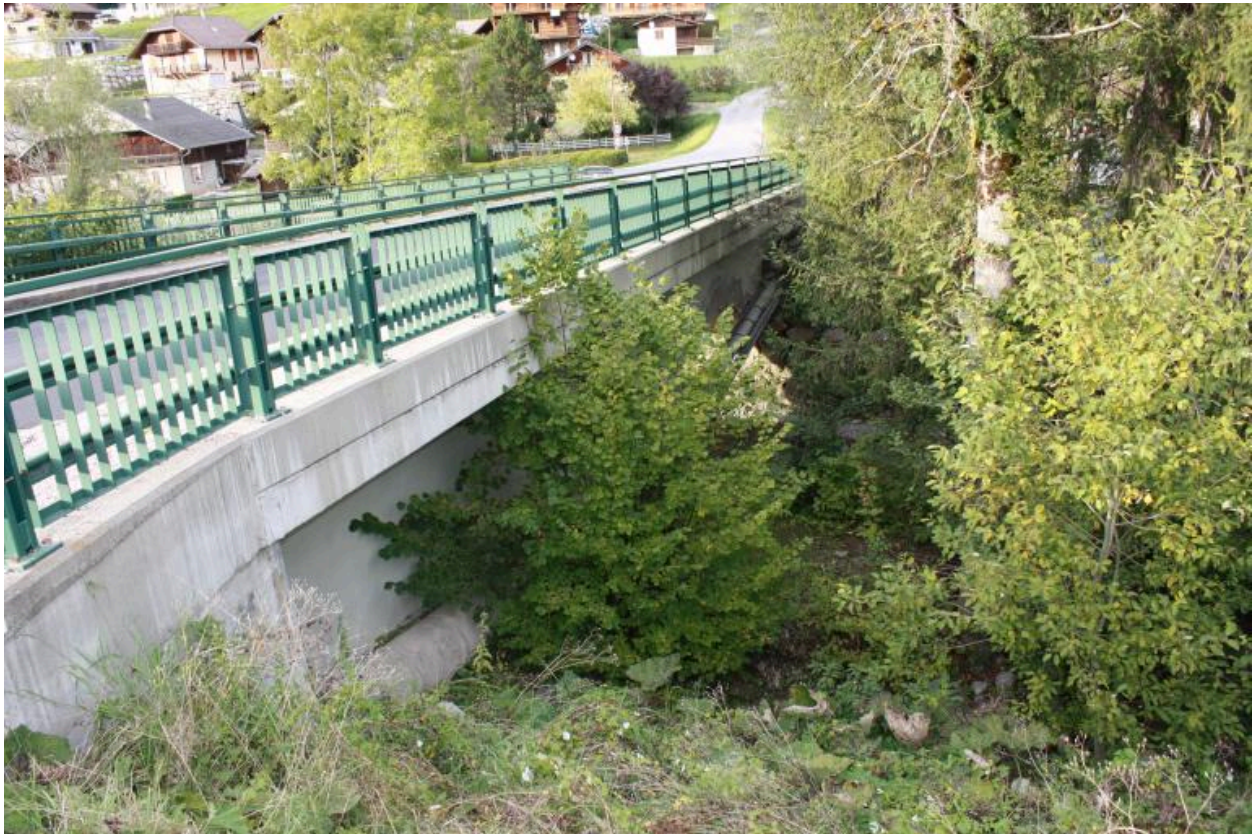
Ponceau de la Glière, face amont
