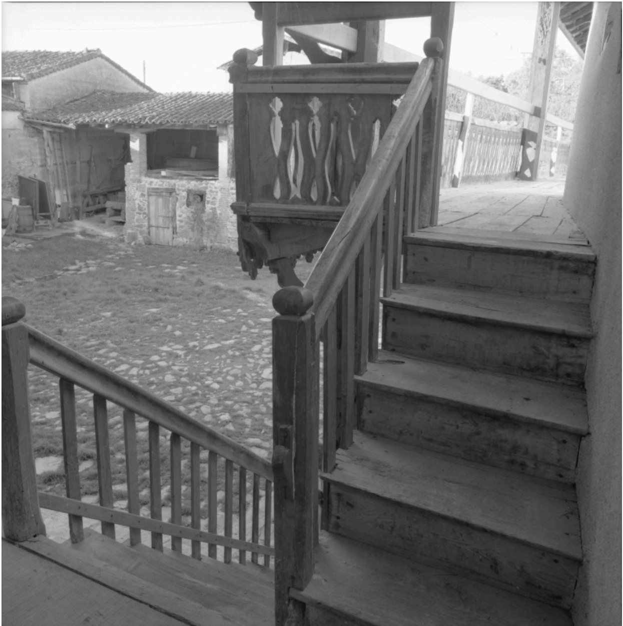
Escaliers d'accès ouest à la galerie du logis, vue depuis le repos.
