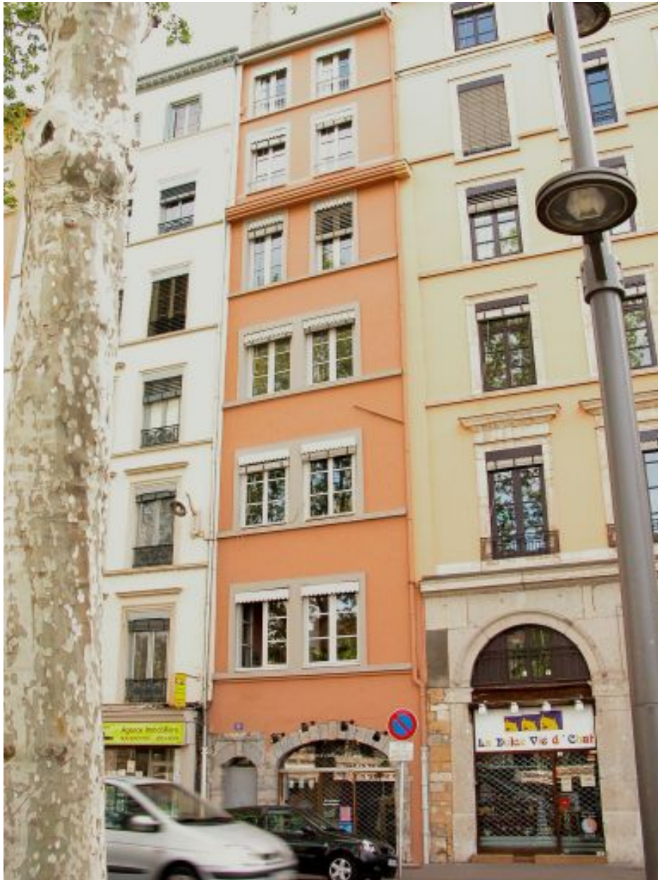
Façade, vue générale
