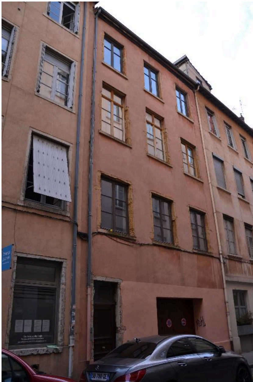
Vue d'ensemble façade ouest
