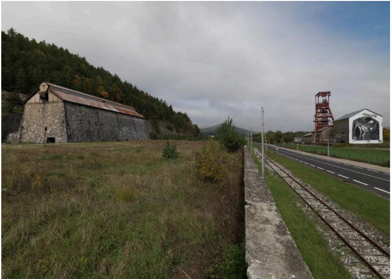
Vue d'ensemble de l'espace minier de la Mure-Villaret
