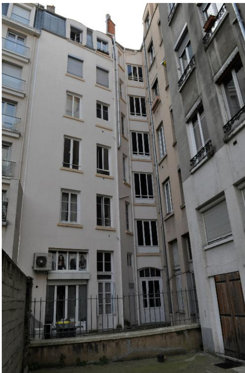
Vue partielle des élévations sur cour
