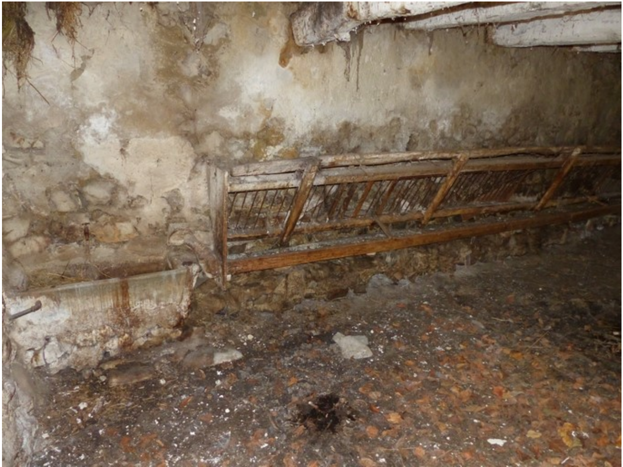
Mangeoire et bassin dans une étable, entrepôt agricole au hameau du Moulin.
