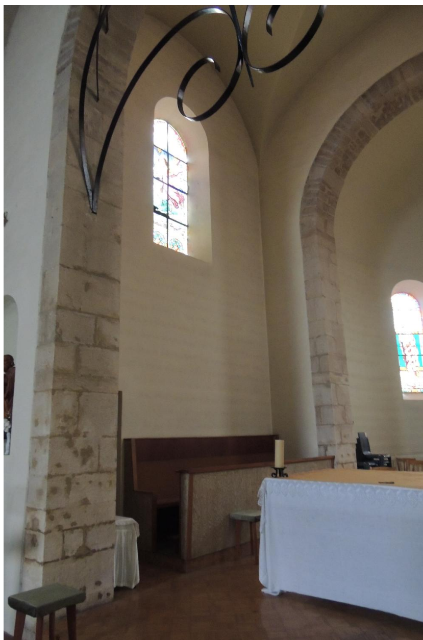
Travée de chœur, élévation nord.
