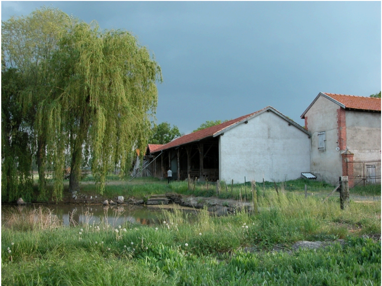
Vue des bâtiments agricoles depuis le sud-ouest : hangar.
