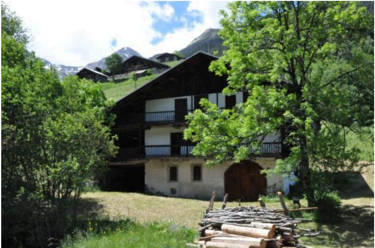
Vue générale du bâtiment.
