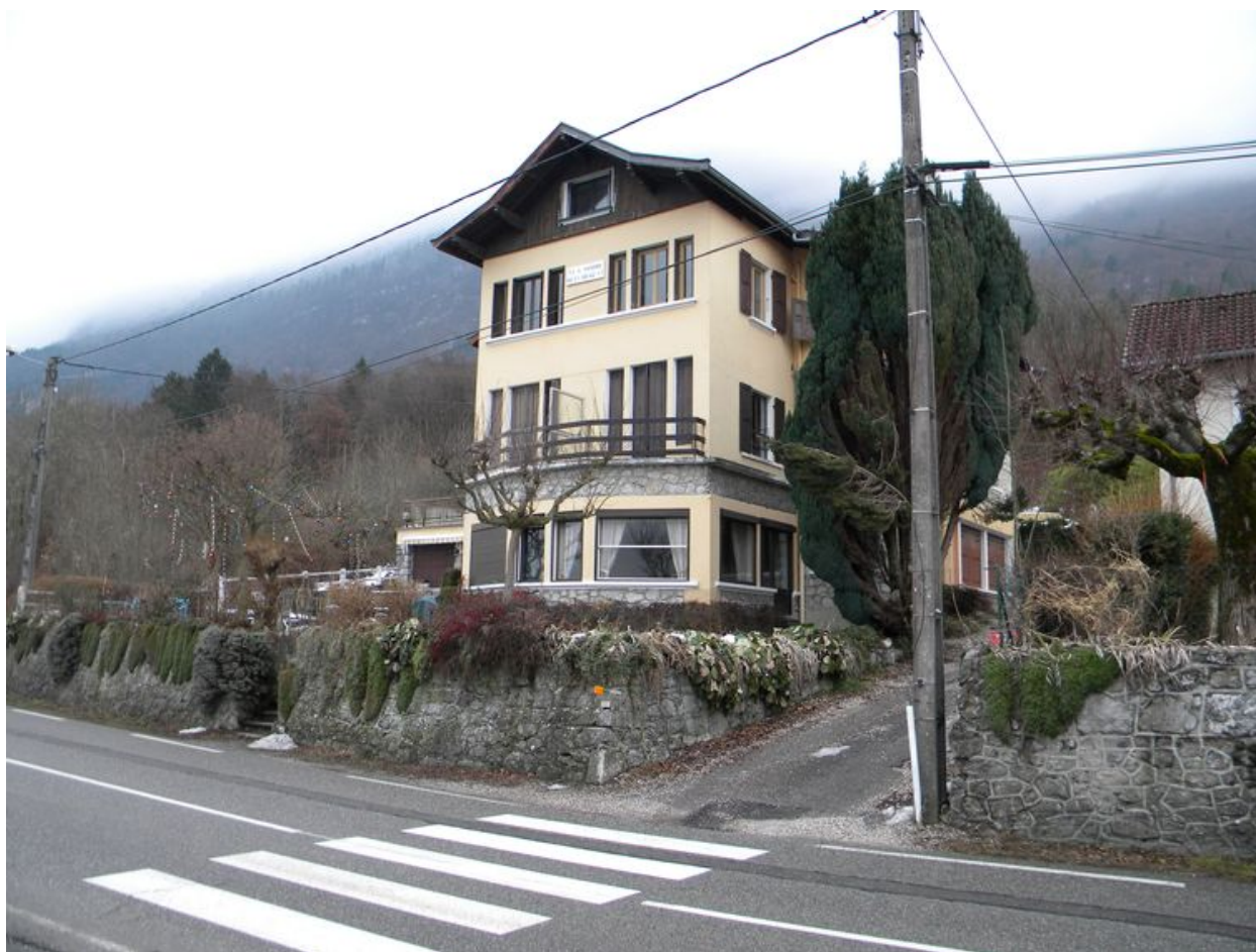
Vue d'ensemble avec bow-windows en avancée.
