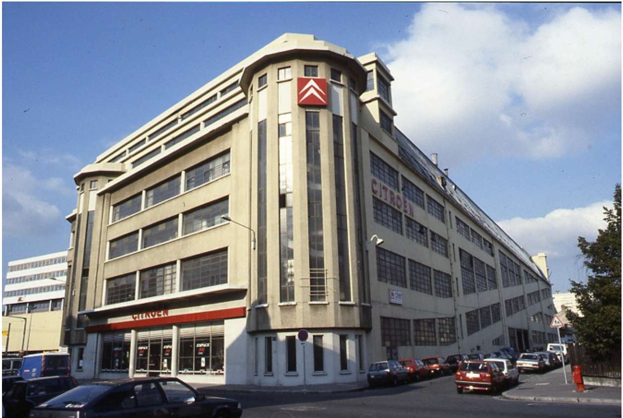
Garage vue sud-est
