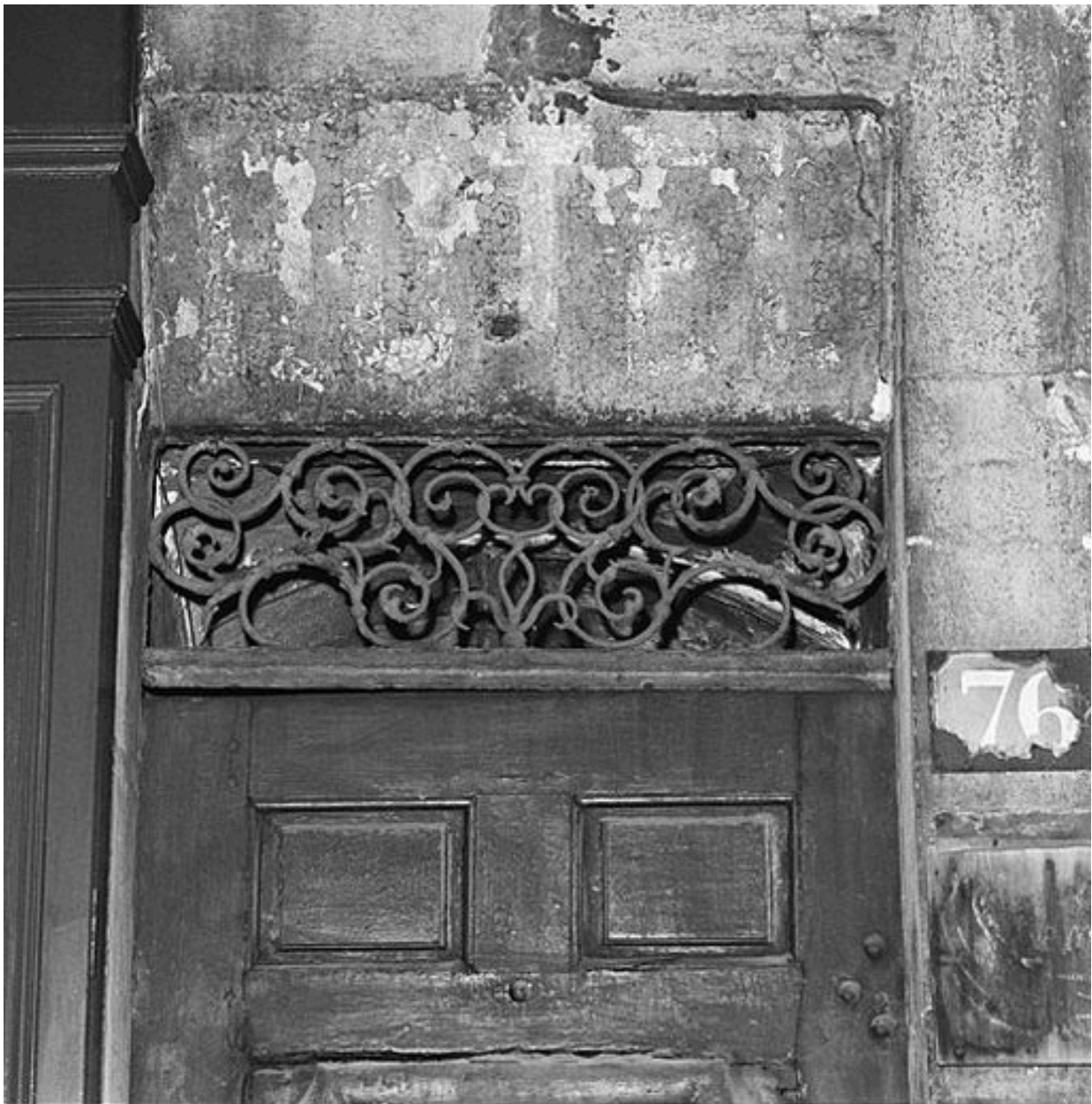
Jour situé au-dessus de la porte piétonne et orné de rinceaux en fer forgé
