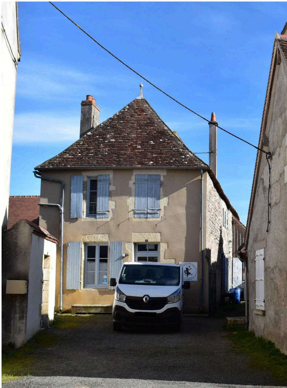
Façade occidentale transformée en pignon de maison couvert en croupe.
