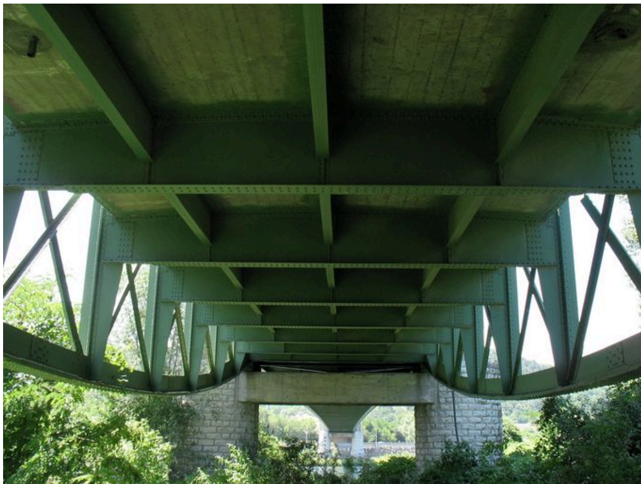
Travée de rive gauche : vue partielle du dessous du tablier
