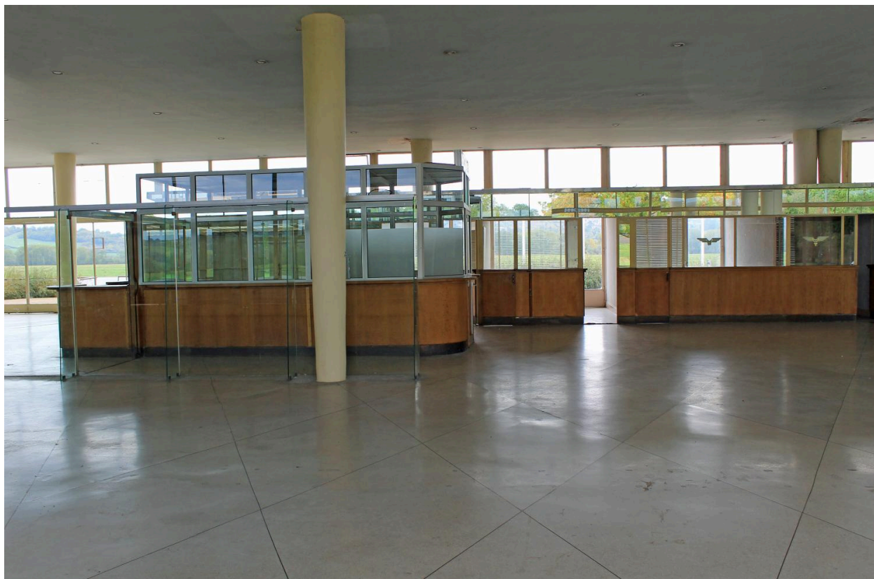
Vue du hall du public de l'aérogare de Vichy-Charmeil.
