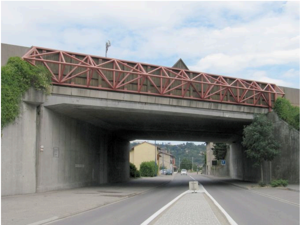
Travée passante en rive droite, face amont
