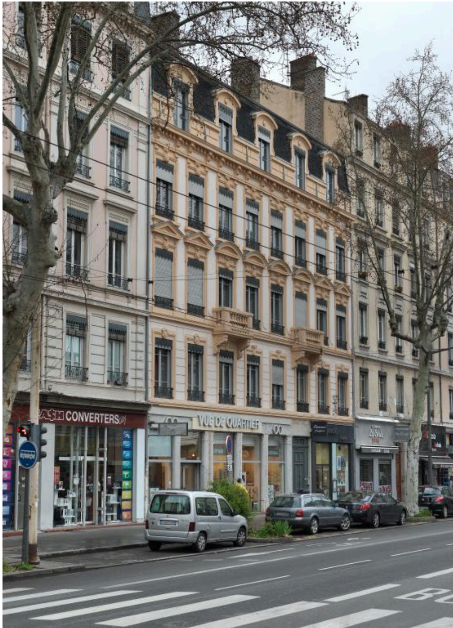
Elévation sur rue, vue d'ensemble
