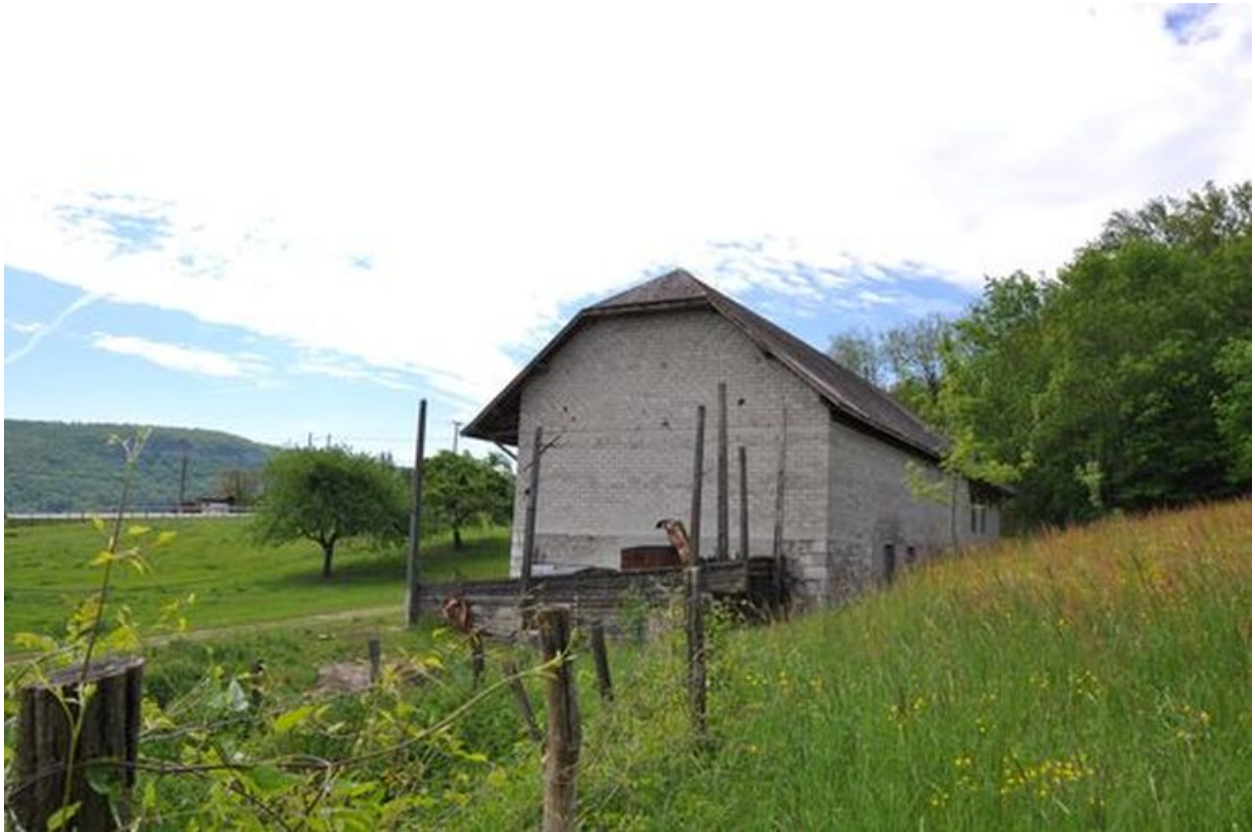
Mur pignon nord du moulin
