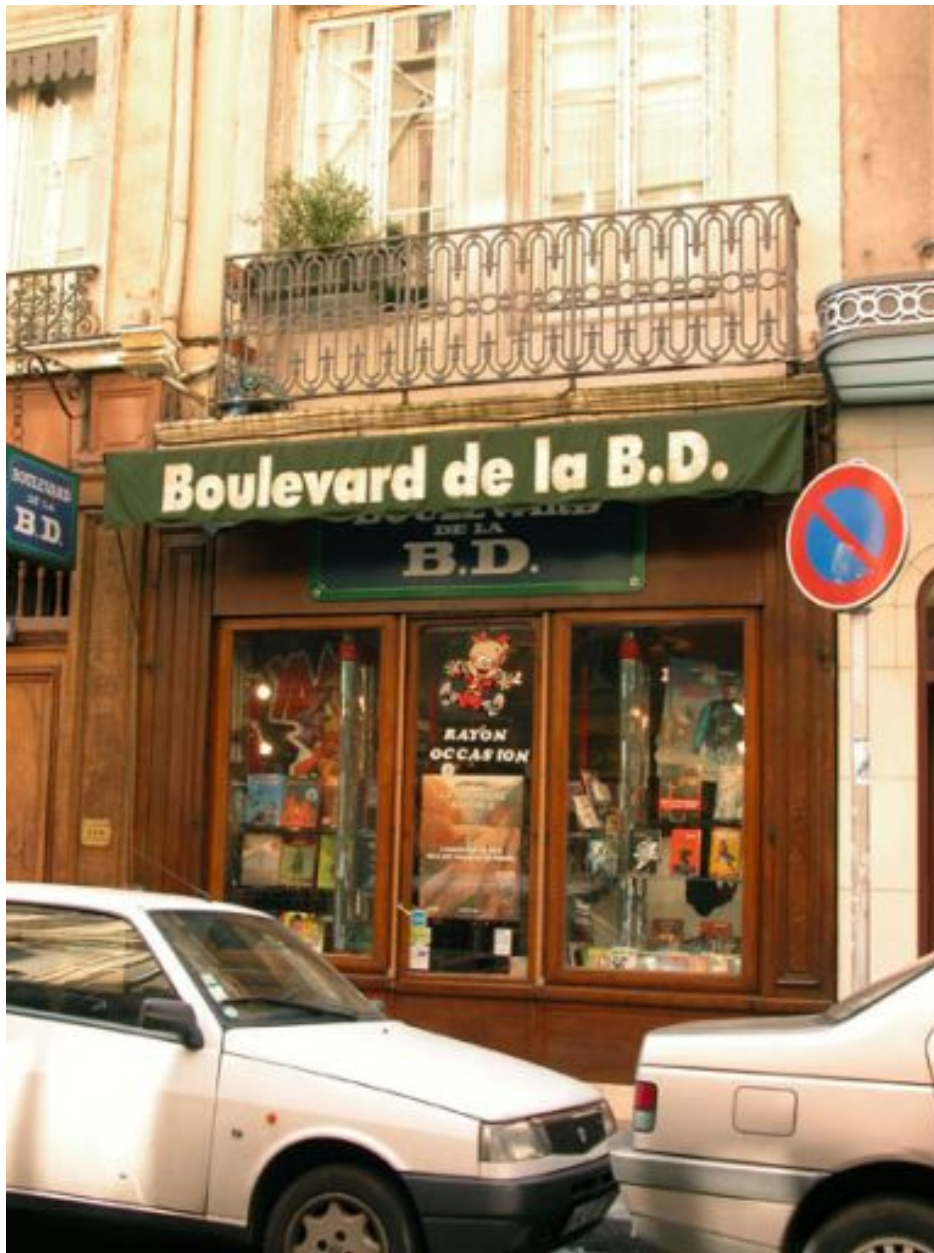
Immeuble de 1856, façade sur rue, 1er niveau
