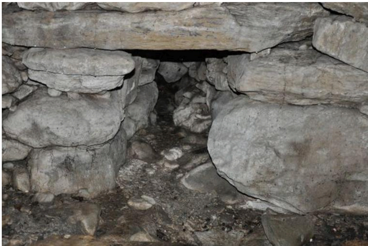
Vue du canal de fuite dans la chambre d'eau souterraine.
