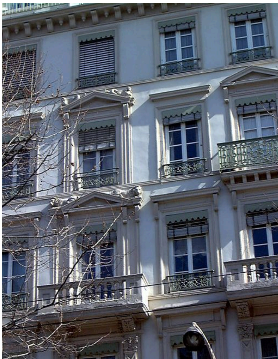
Façade sur rue, détail des étages
