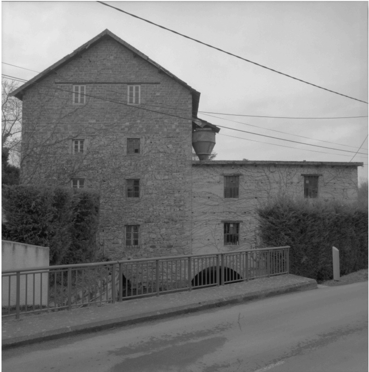
Vue d'ensemble, depuis la route, du moulin de Bindos.
