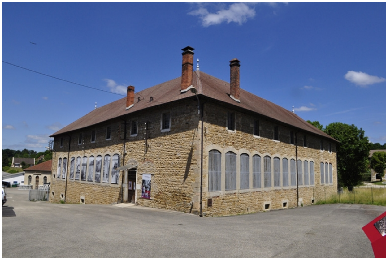
Vue extérieure de la forge
