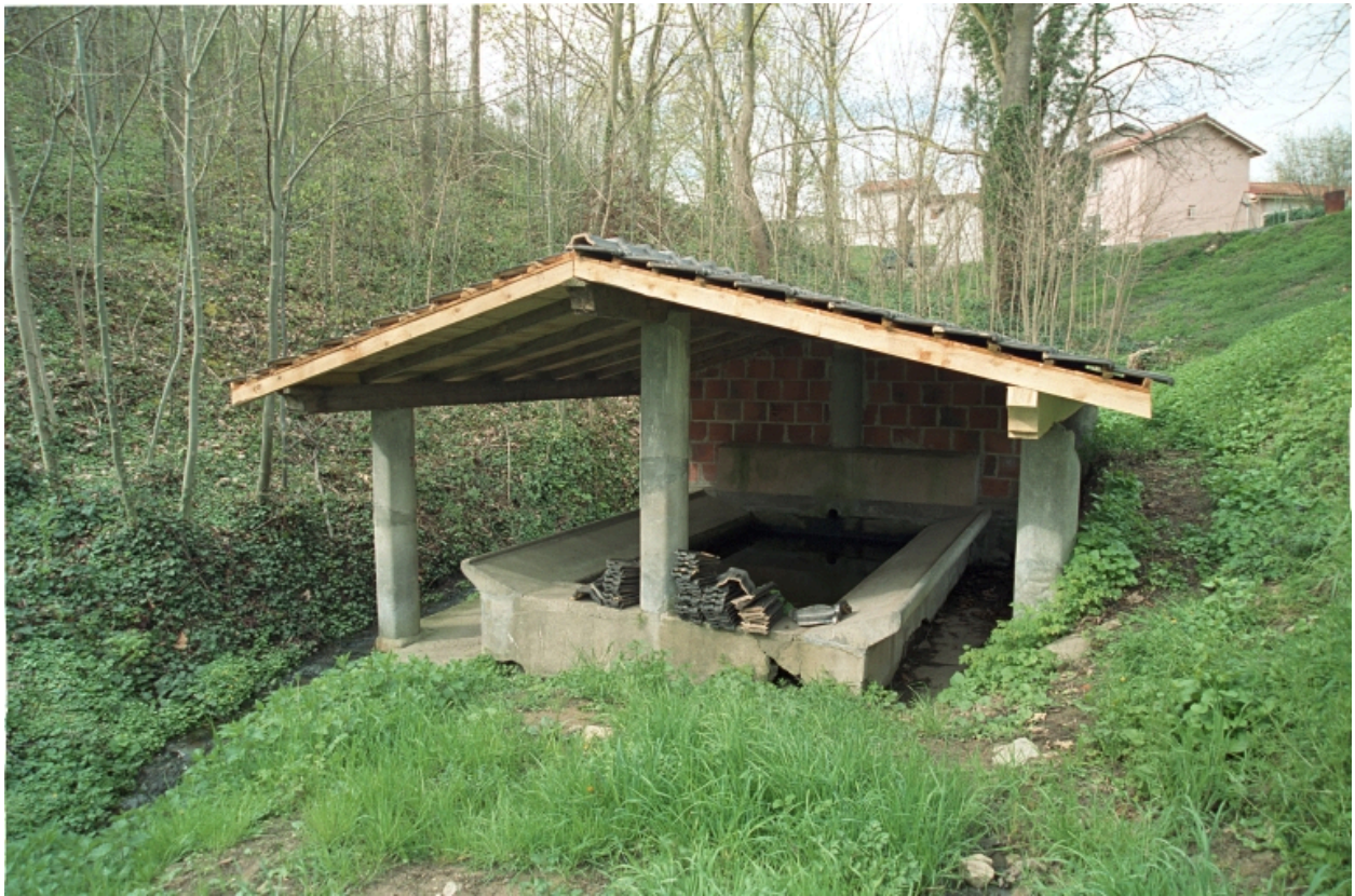
Vue d'ensemble du lavoir des Trouillères (1987 A1 64, 65).
