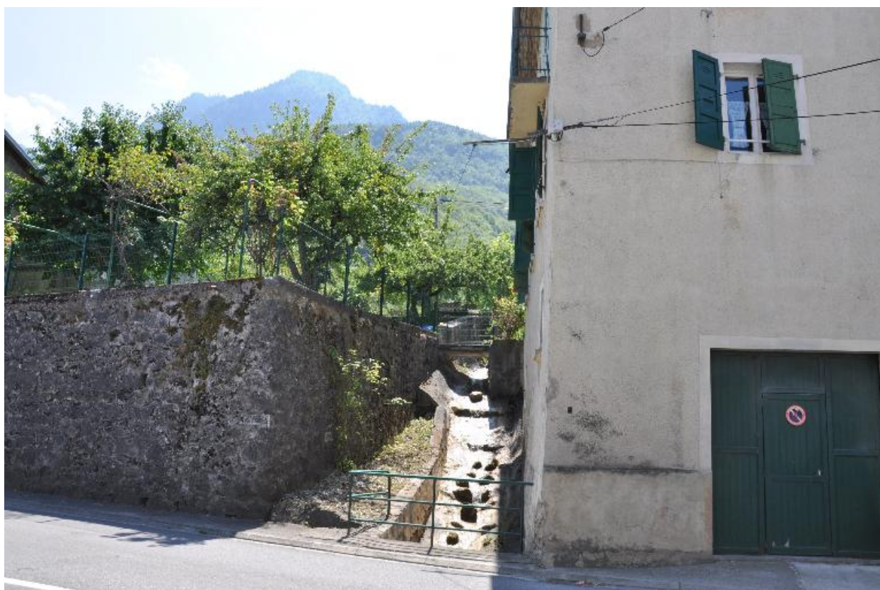
Détail du canal de dérivation busé se trouvant du côté de la façade latérale est
