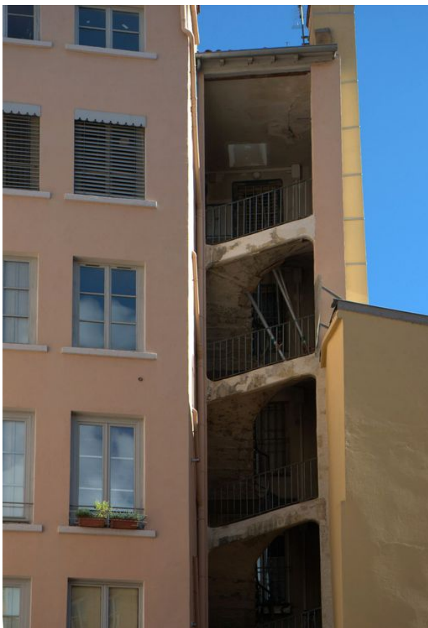
Elévation postérieure, détail de la cage d'escalier
