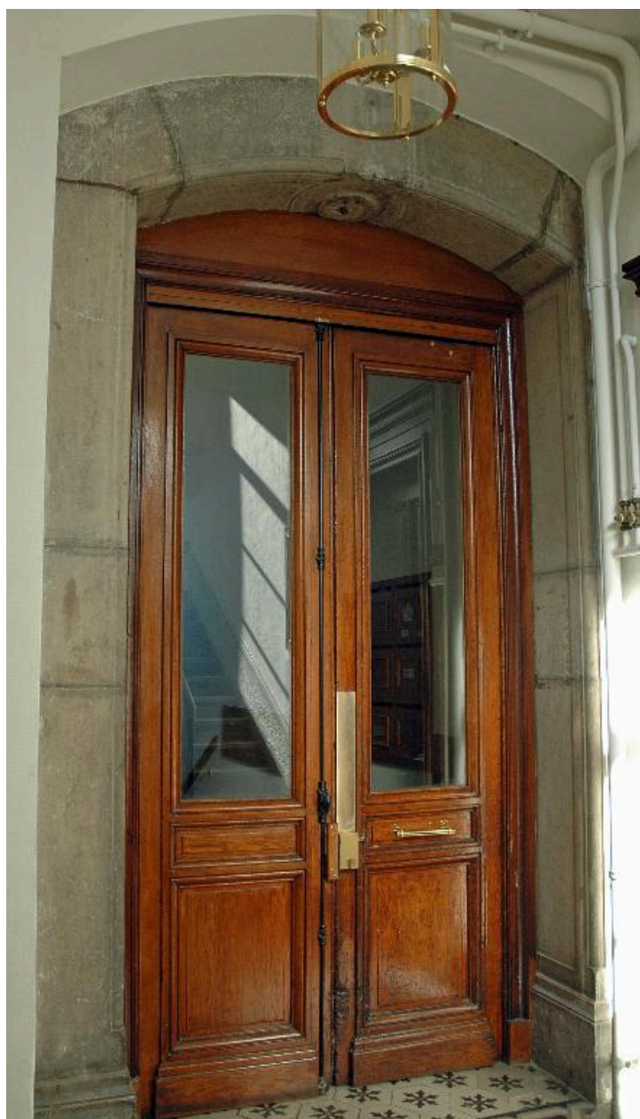
Vue intérieure du bâtiment sur quai : la porte du vestibule-sas
