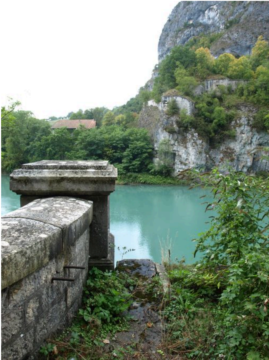
Vestiges de la culée sud (rive gauche) ; vue sur le débouché
