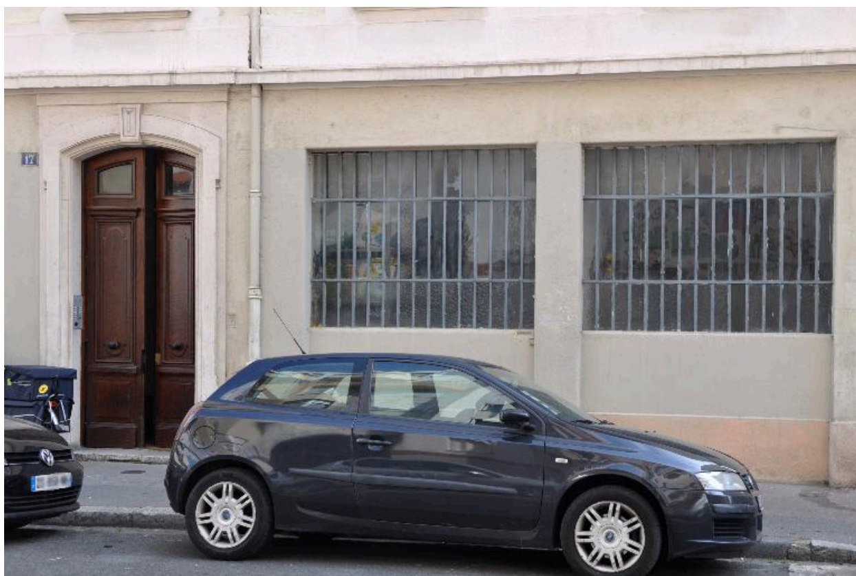
Immeuble, vue de la porte et atelier en rez-de-chaussée
