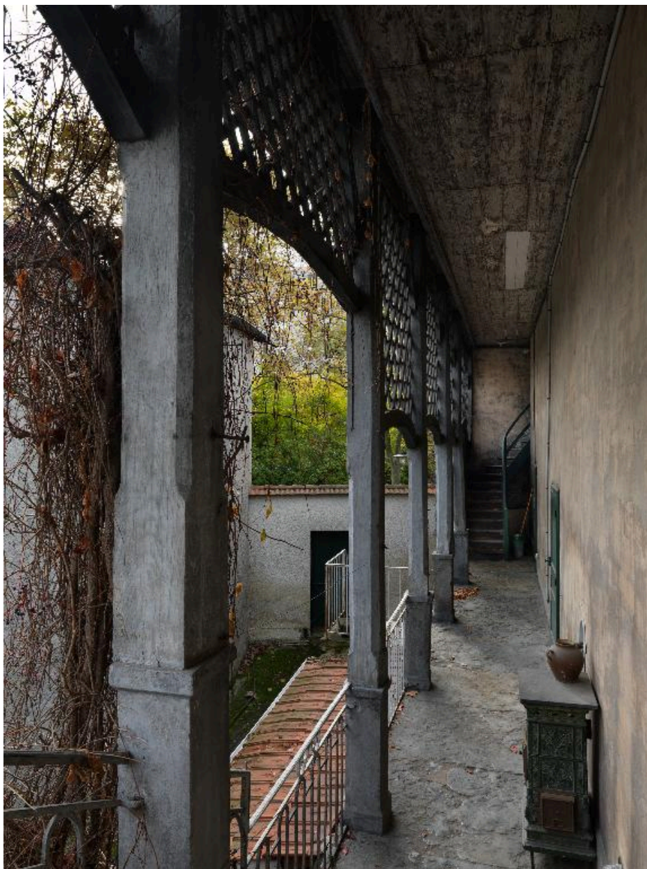
Galerie, vue depuis le nord
