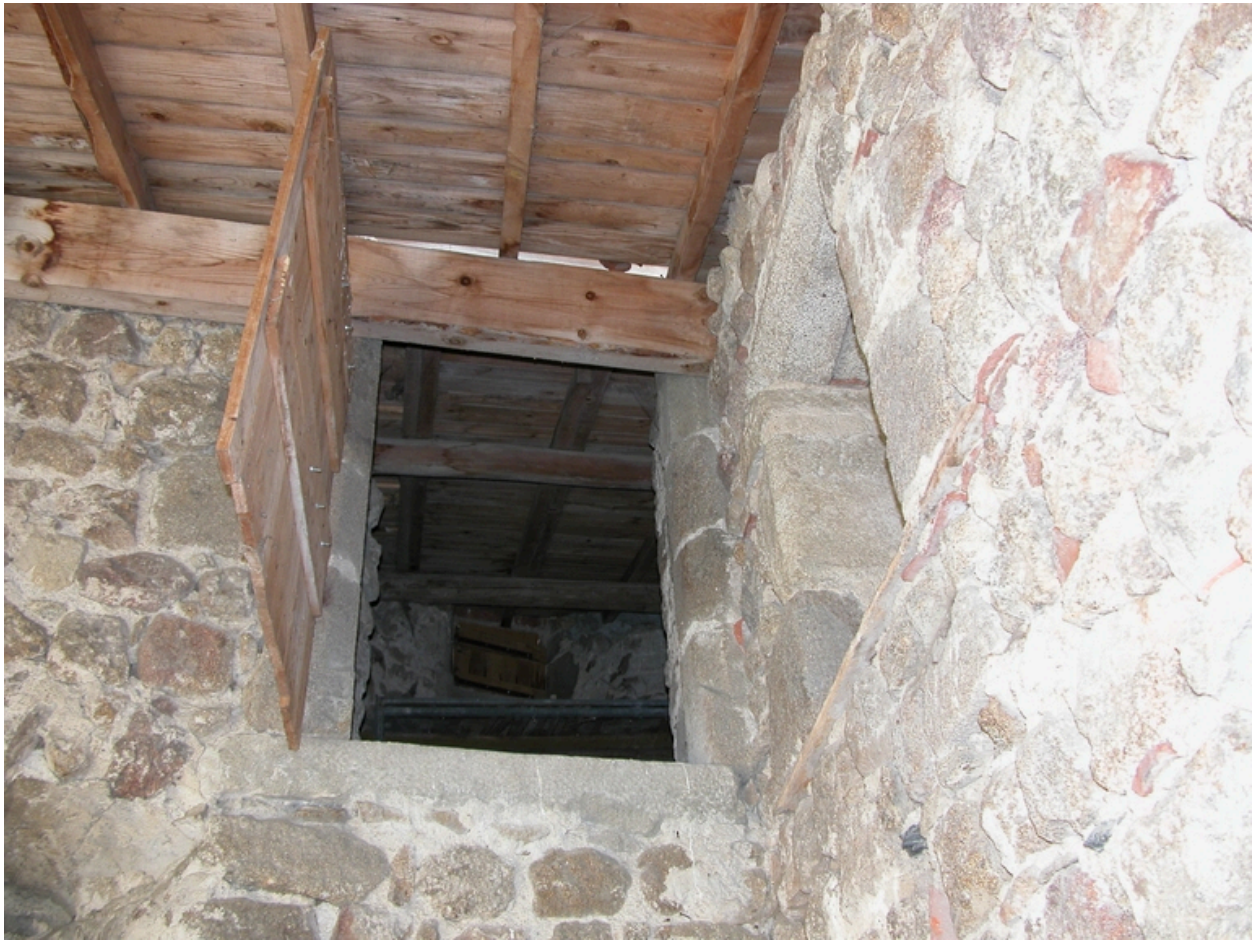
Porte à l'étage de comble.
