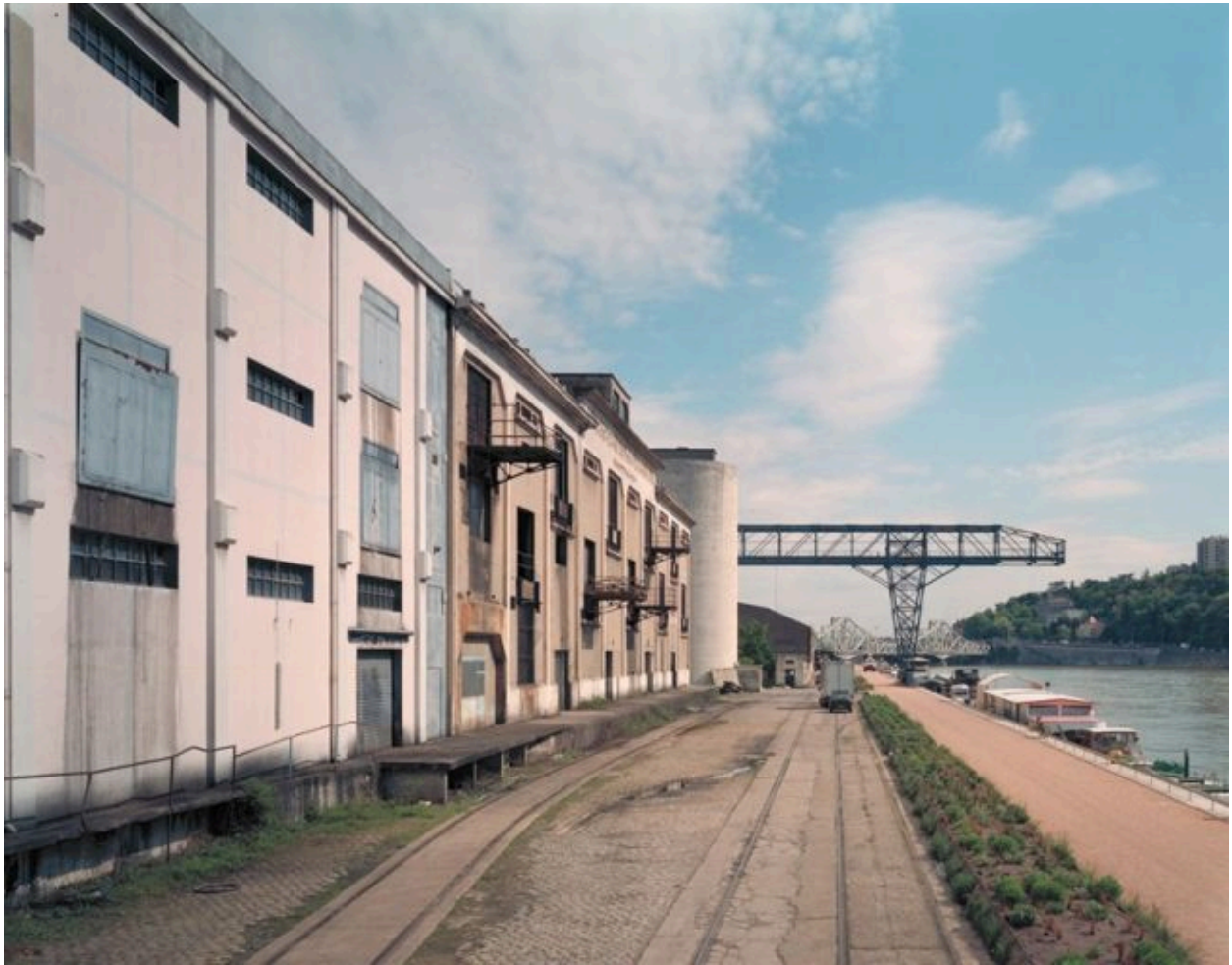
Élévation occidentale, partie sud
